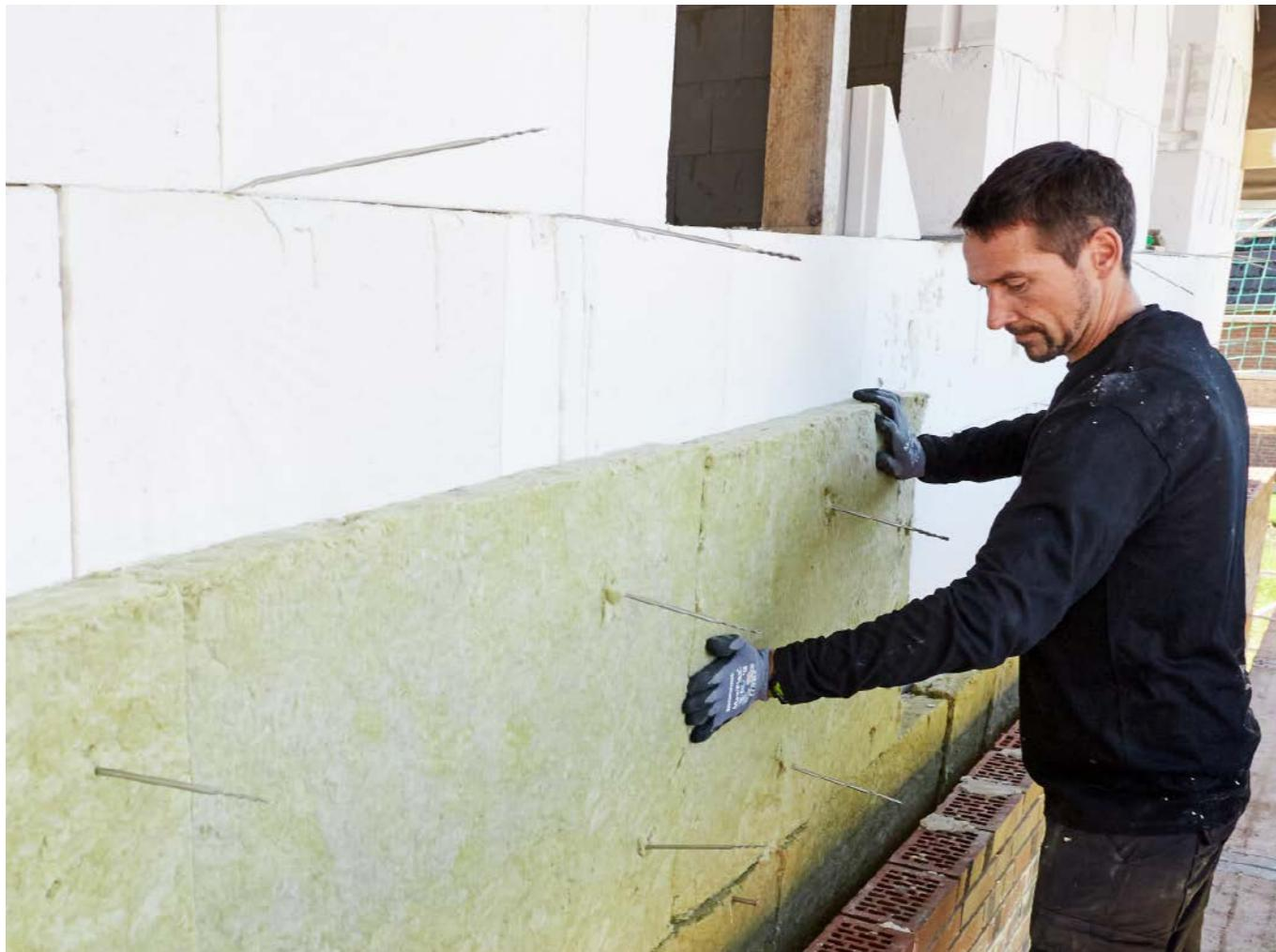
ROCKWOOL Kernrock Dämmpfatten sind sehr formstabile Steinwolle-Produkte. Sie sind nachgewiesen bewitterungsfest und zeichnen sich durch eine sehr hohe Robustheit bei gleichzeitig einfacherem Handling aus.
