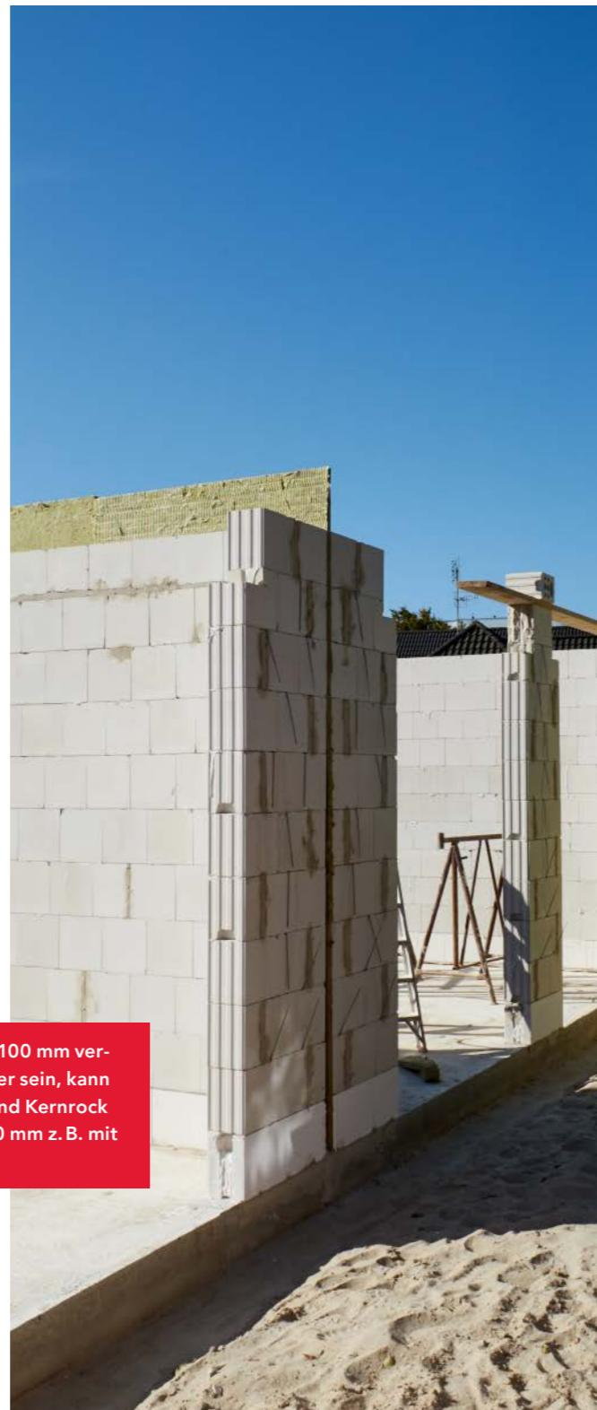
Splitrock MW kann zweilagig bis maximal 100 mm verlegt werden. Sollten die Trennfugen größer sein, kann mit einer Kombination aus Splitrock MW und Kernrock gearbeitet werden, bei einer Fuge von 200 mm z.B. mit 40 mm Splitrock MW + 160 mm Kernrock.
