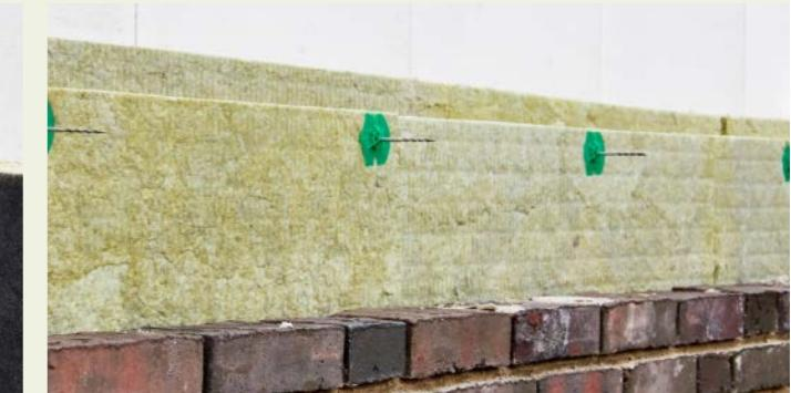
Die Dämmstoffplatten werden im Verband verlegt und so auf die Mauerwerksanker aufgebracht, dass sie dicht gestoßen ohne Fuge an der Wand und an der nächsten Platte anliegen. Durch die Struktur der Steinwolle-Dämmplatten verfilzen die Plattenstoße miteinander, sodass eine dichte und gleichmäßige Verlegung entsteht.
