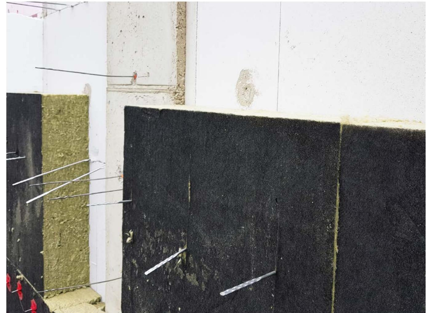
Die vlieskaschierten Kerndämmplatten verfügen über die gleichen Vorteile wie die unkasierten Produkte. Sie lassen sich ebenfalls leicht auf die vormontierten Mauerwerksanker aufbringen und ermöglichen eine schnelle und problemlose Verlegung.
